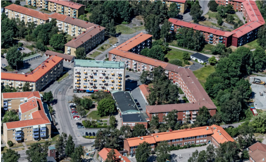
Flygbild över befintlig bebyggelse från söder.
